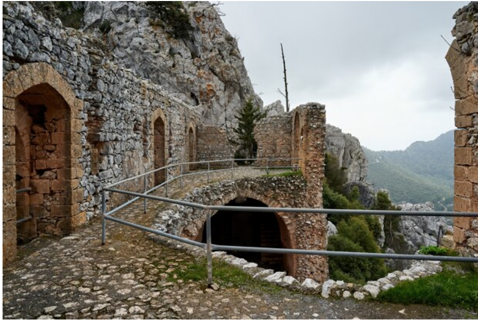
ZDJĘCIE - 1: Old ancient building in a city
